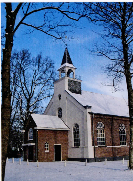
De Gereformeerde Kerk van Berghuizen-Ruinerwold.
